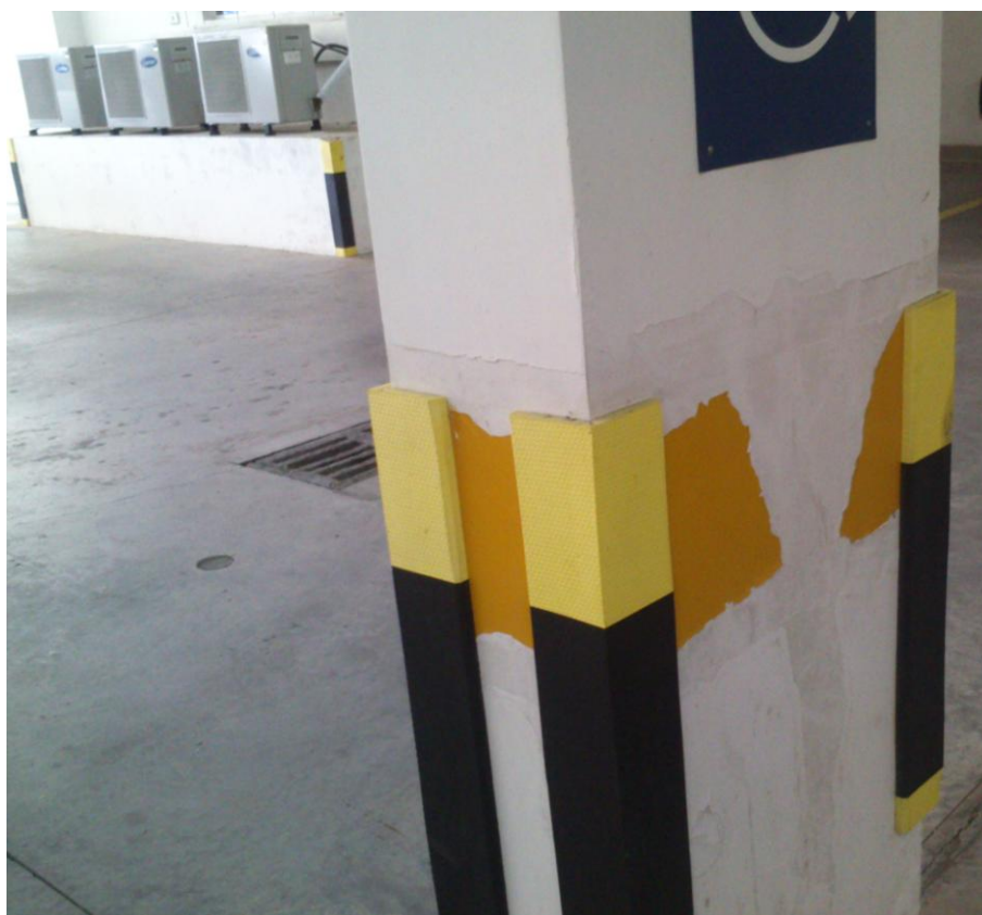
FOTO 20- EXEMPLO DE PAREDES QUE TERÃO QUE SER REPARADAS E PINTADAS (SERVIÇO 05)
