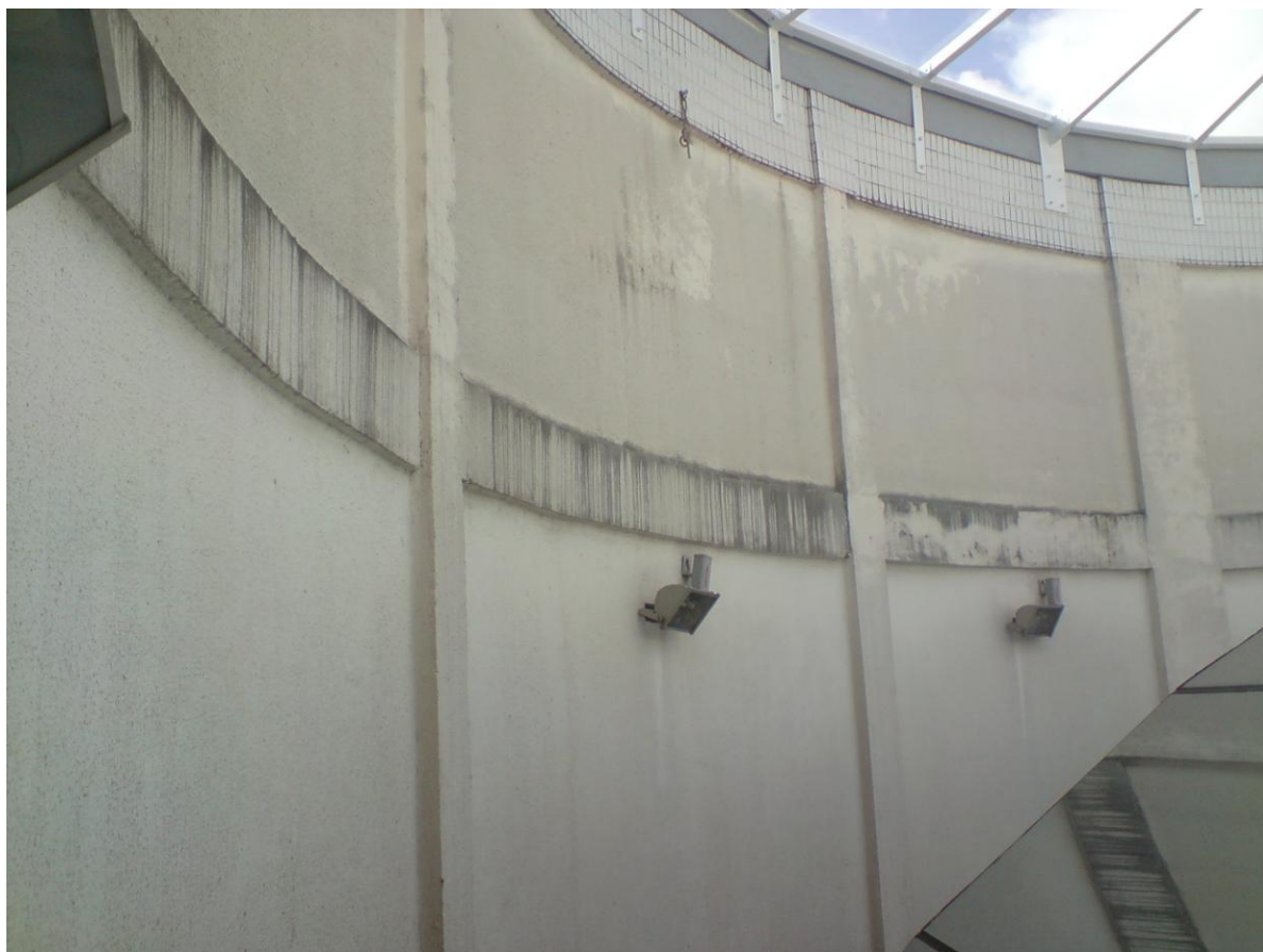
FOTO 32- PAREDE INTERNA ENTRE AS DÚAS CÚPULAS (SERVIÇO 06)
