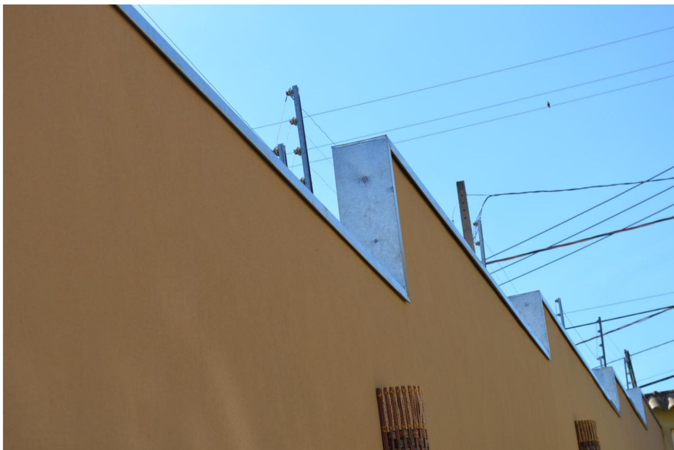
IMAGEM 03 – ILUSTRAÇÃO DE INSTALAÇÃO DE RUFOS (SERVIÇO 07)
